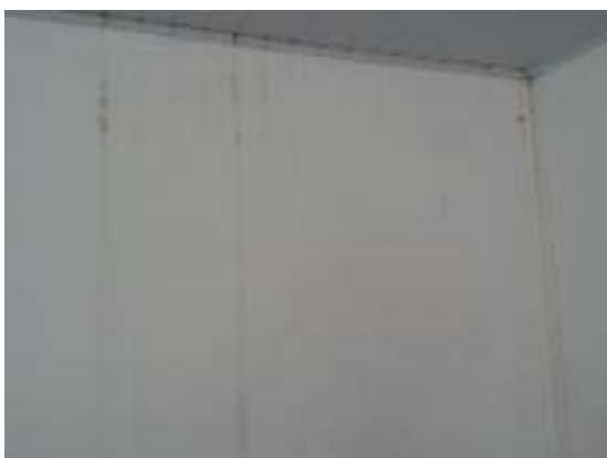
Fotos 19 e 20 – Qualidade deficiente na execução da cobertura (infiltrações) e na execução dos rodapés em granitina
