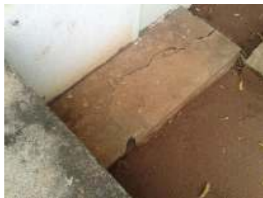
Fotos 17 e 18 – Qualidade deficiente na pintura das esquadrias metálicas, na execução do forro em PVC e na execução da calçada
