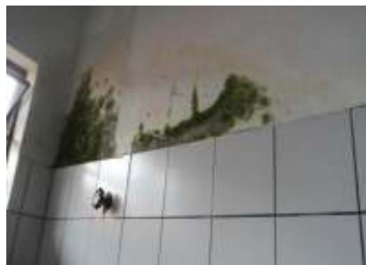
Fotos 21 e 22 – Qualidade deficiente na execução do piso em granitina e na execução das instalações hidráulicas (infiltrações)
