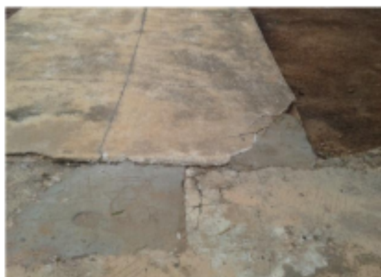
Fotos 15 e 16 – Qualidade deficiente na execução do revestimento das paredes na parte do oitão e na execução do passeio (calçada)
