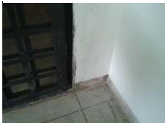
Fotos 19 e 20 – Qualidade deficiente na execução da cobertura (infiltrações) e na execução dos rodapés em granitina
