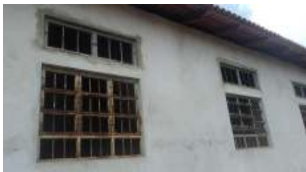
Fotos 03 e 04 – Obra abandonada, esquadrias metálicas em estado de corrosão e muita sujeira nas partes internas.
