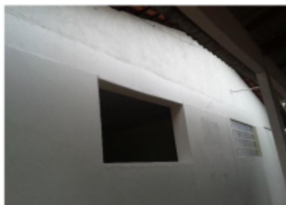
Fotos 15 e 16 – Qualidade deficiente na execução do revestimento das paredes na parte do oitão e na execução do passeio (calçada)
