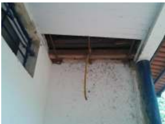
Fotos 17 e 18 – Qualidade deficiente na pintura das esquadrias metálicas, na execução do forro em PVC e na execução da calçada
