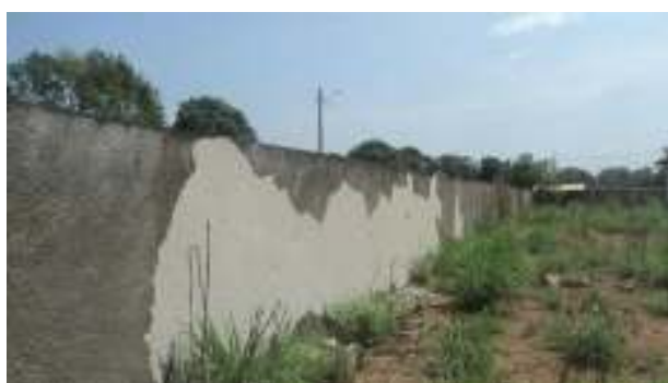
Fotos 05 e 06 – Obra abandonada, sinais de vandalismo e desgaste no revestimento de parede interna e muro.
