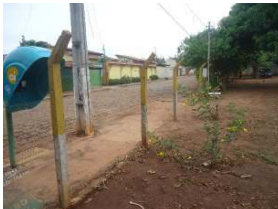
Fotos 09 e 10 – Alambrado sem tela, não executado pela Contratada
